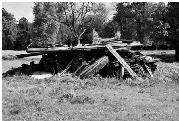
Bodzechów, pozostałości po rozbiórce ostatniej oficyny
