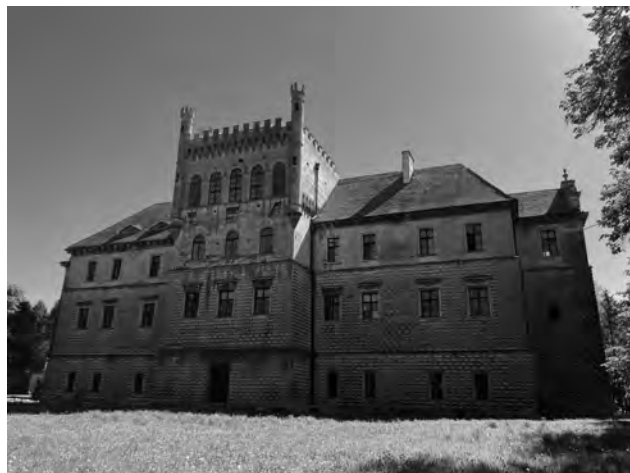
Pałac na Mirowie w Książu Wielkim od zachodu, bud. Santi Gucci (ok. 1530-1600), k. XVI w., później przebudowywany, fot. Karina Berkowicz
